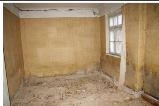
Pirts ēka ar kadastra apzīmējumu 6448 005 0091 004
