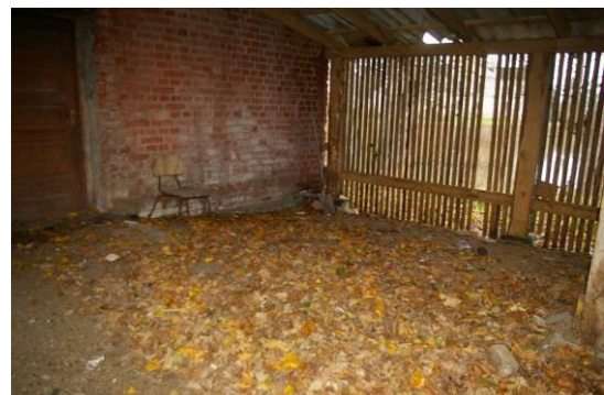
Šķūņa ēka ar kadastra apzīmējumu 6448 005 0268 001
